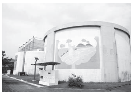
上水道タンク
