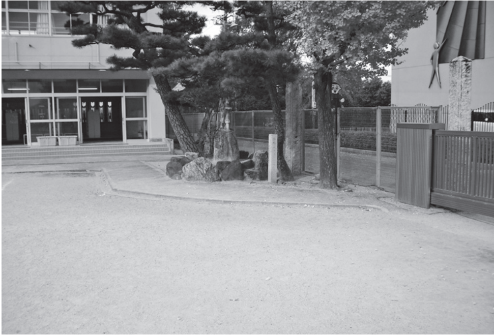
▲スロープ化する東昇降口
