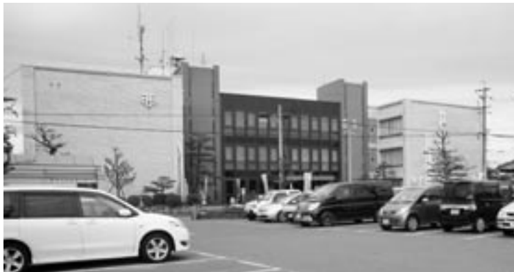
耐震補強工事を行う庁舎、公民館
