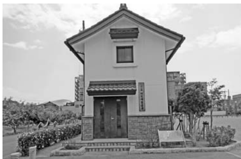
八切公園防災備蓄倉庫
