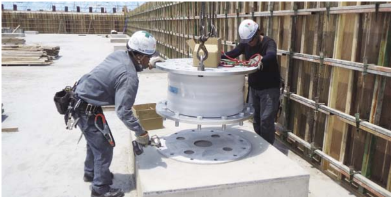
積層ゴム設置中
