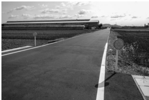
町道381号線 (高屋石末一丁目交差点東側)
