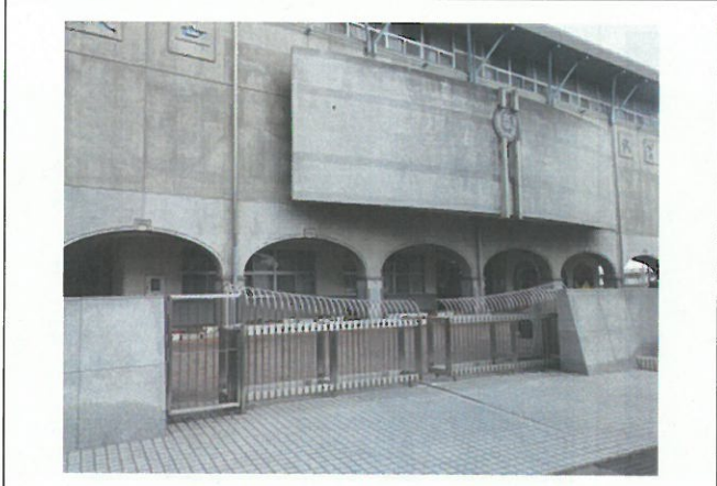
・西北側出入口
