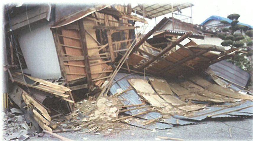
出典：災害廃棄物対策フォトチャンネル「平成 28 年熊本地震・被害状況」
