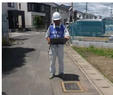
■写真 3-1 配水管漏水調査状況
