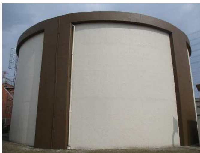
■写真 3-2 1号配水池
