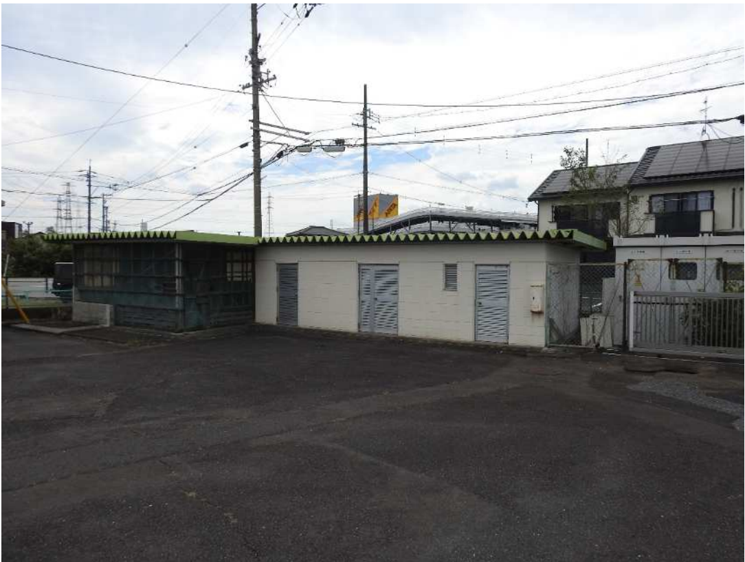
倉庫（敷地北西角）
