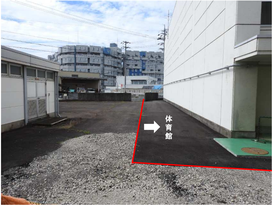
体育館との西側境界を南から撮影（フェンスを設置すること）
