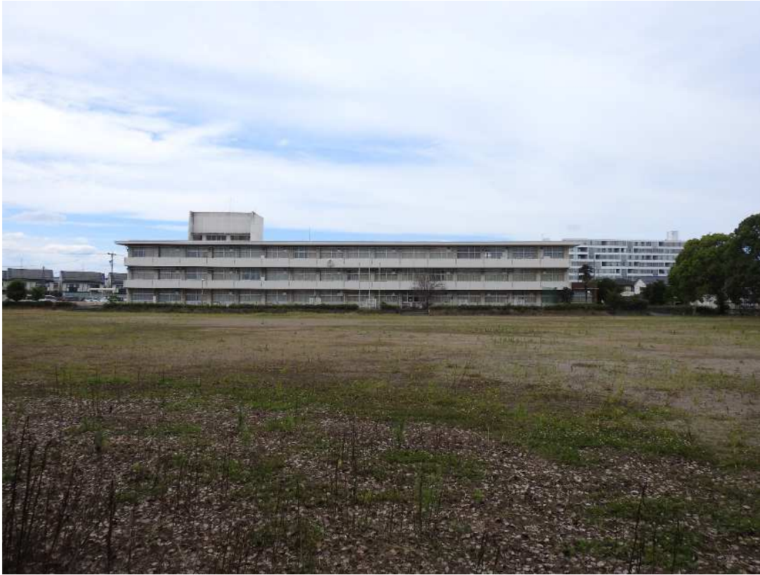
校舎を南から撮影
