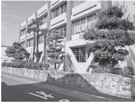
◀ 庁舎南側（耐震補強）
