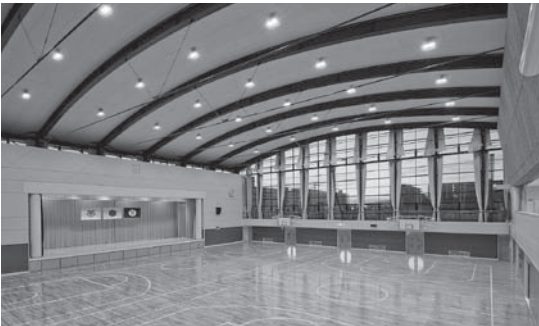
◀改修後の北方小学校体育館
