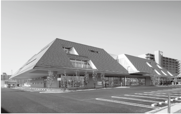
▲ 完成した新庁舎
