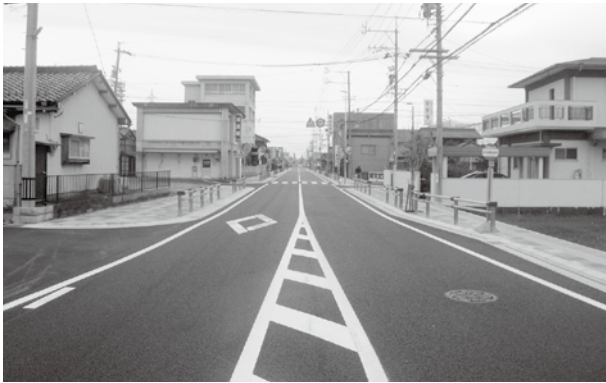
▲ 工事後の町道3号線
