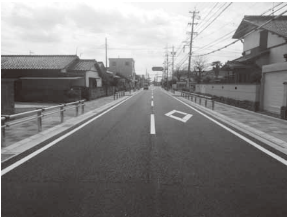
▲ 工事後のグリーン通り
