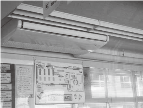
▲ 設置されたエアコン
