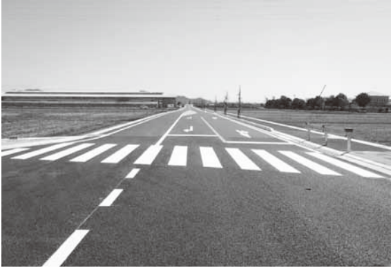
▲ 工事後の町道 381 号線
