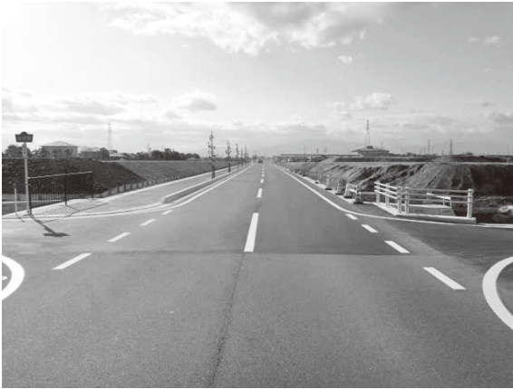
▲ 工事後の町道 381 号線
