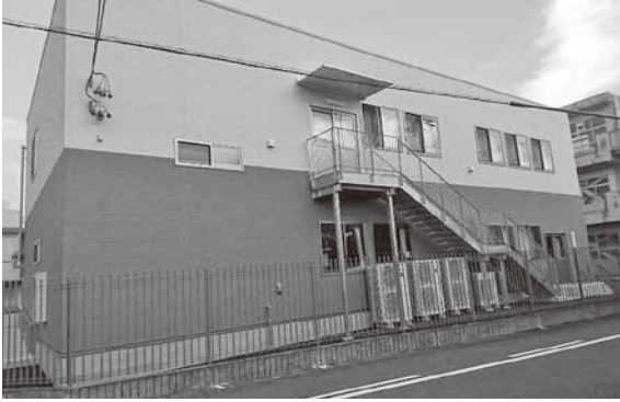
▲ 完成した学童棟
