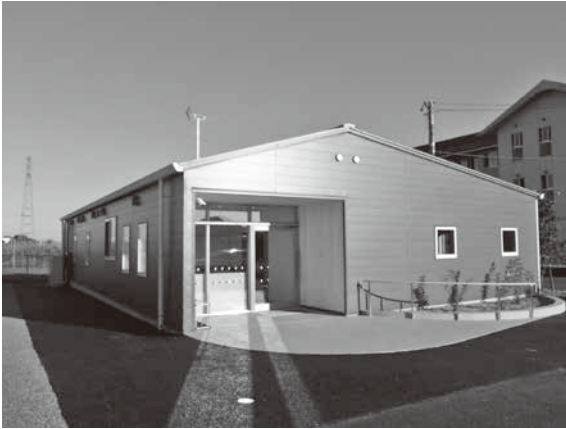
▲ 完成した学童保育棟
