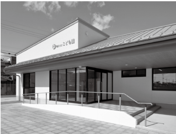
▲ 完成した園舎
