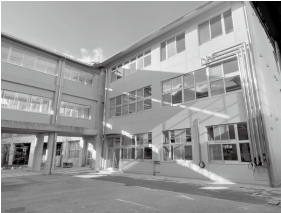
▲ 完成した特別教室棟
