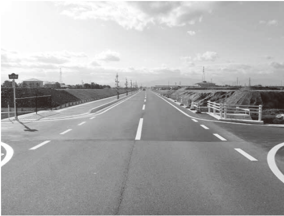
▲ 工事後の町道 381 号線
