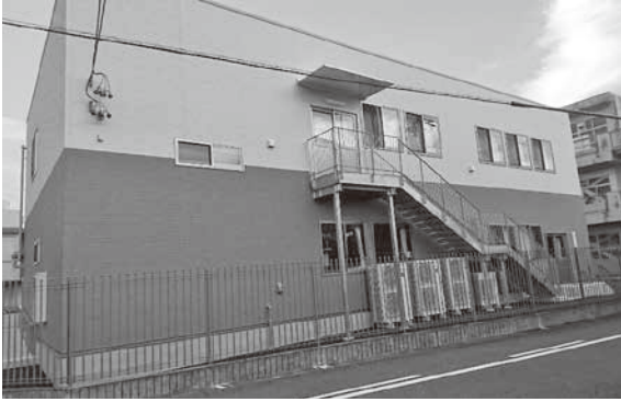
▲ 完成した学童棟
